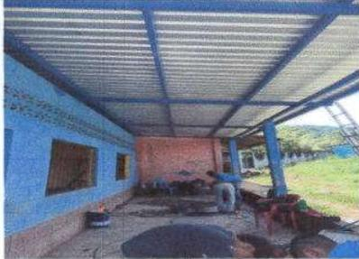
FOTO 7: PROCESO DE Sustitución de estructura de soporte de madera, por metal (AULA)
