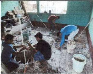
FOTO 9: PROCESO DE Reparación de piso de torta de concreto (COCINA)
