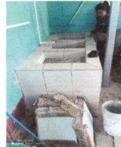
FOTO 10: PROCESO DE Sustitución de Azulejo de Pila (COCINA)
